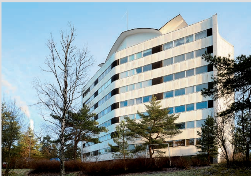
Vuonna 1959 rakennettuun Tapiolan Tornitasoon valittiin pipemodul-ratkaisu
