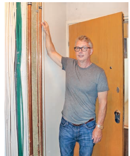
Talossa saattoi asua remontin aikana. Kuvassa uudet putket ja johdot porrashuoneen moduulissa.
