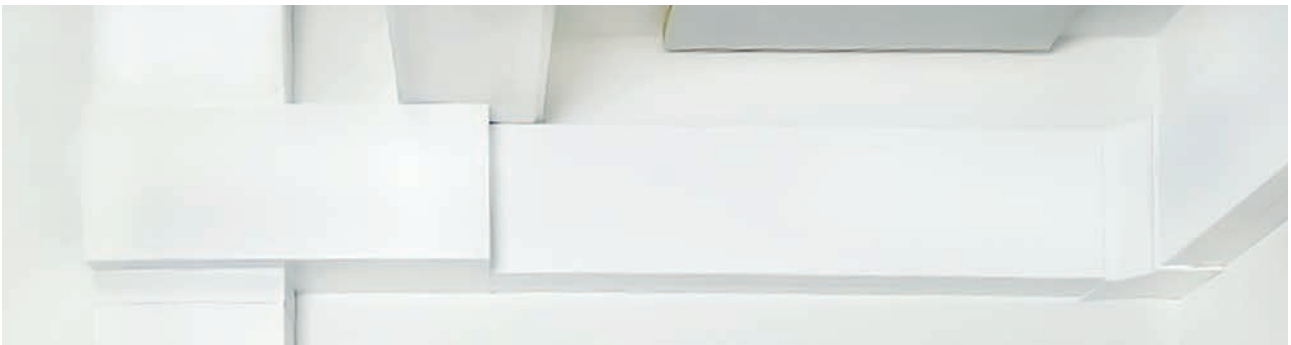
Moduulit valmiina porrashuoneessa.
