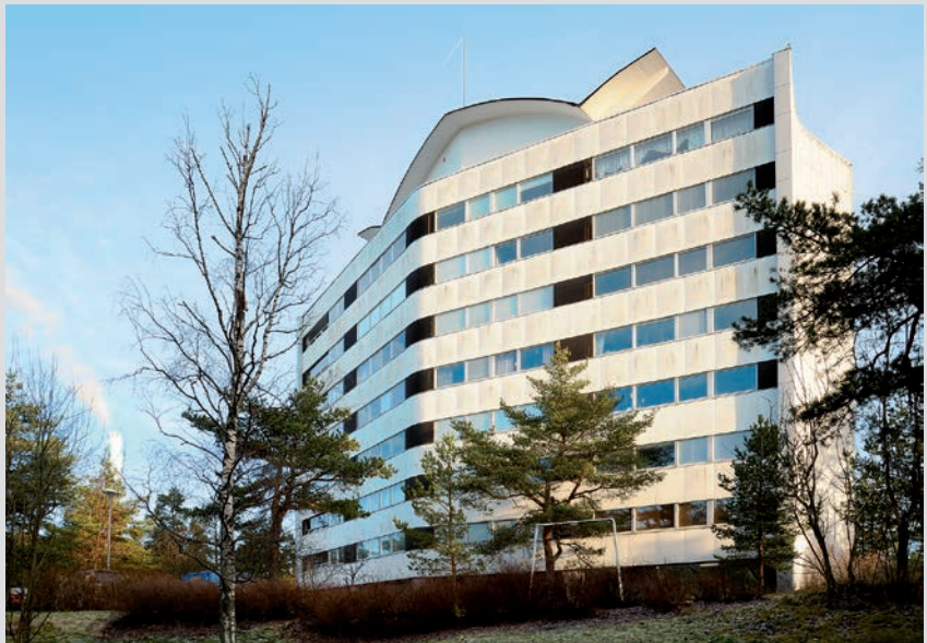
Vuonna 1959 rakennettuun Tapiolan Tornitasoon valittiin pipemodul-ratkaisu
