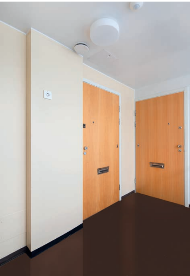
Porrashuoneen sävyyn paikan päällä maalattu moduuli.
