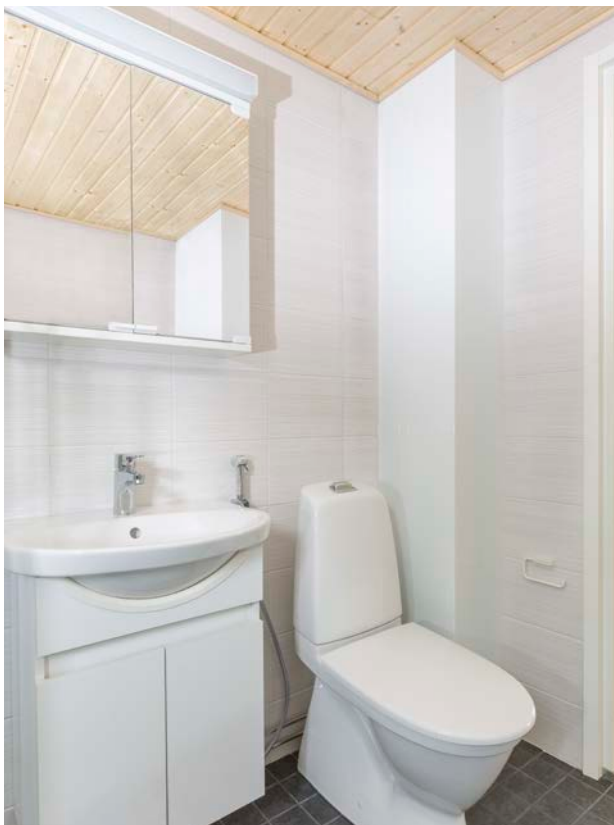
Vesi ja viemäri -yhdistelmämoduuli kylpyhuoneessa.
