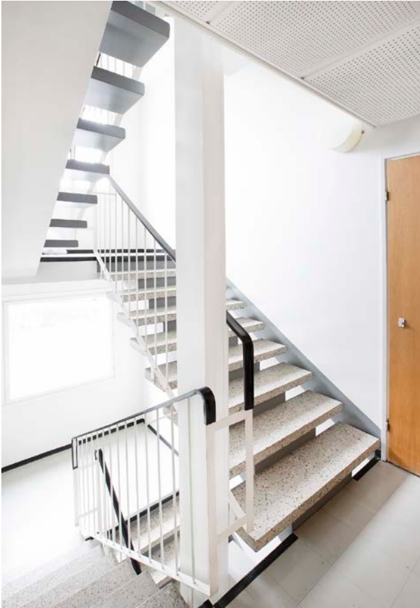
Pystymoduuli kuiluasennuksena portaiden keskellä.
