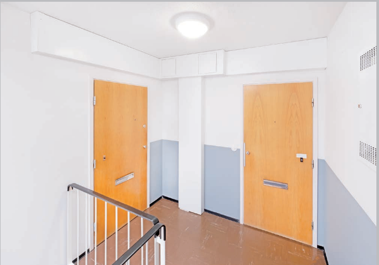
Modernin putkiremontin jälkeen uudet vesijohdot ja sähkökaapelit porrashuoneen moduuleissa.
