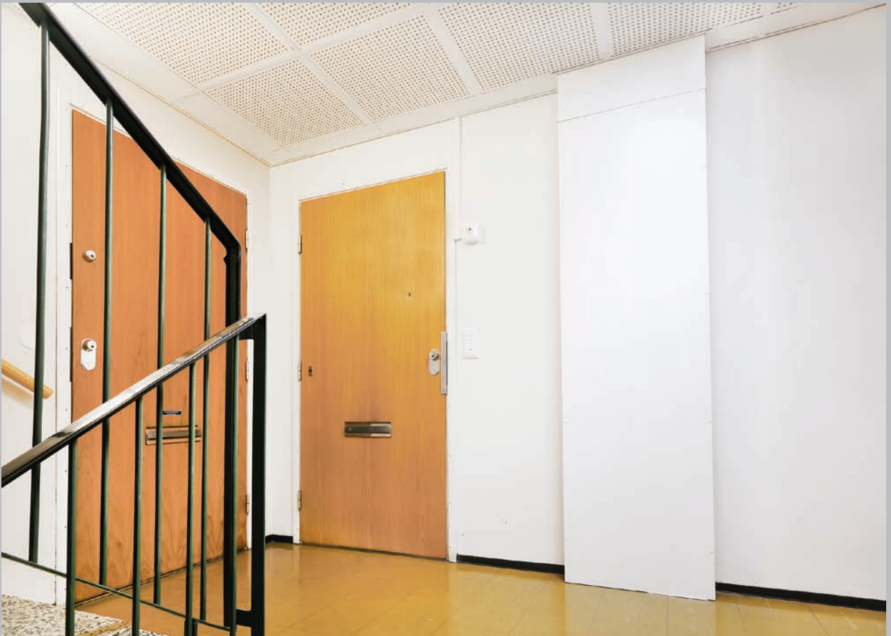
Modernin putkiremontin jälkeen uudet vesijohdot ja sähkökaapelit porrashuoneen moduuleissa.
